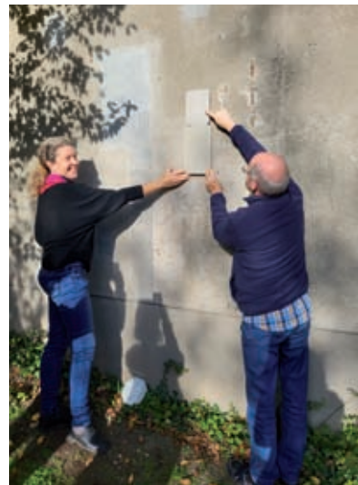
Auch der Farbton bei der Beton- sanierung muss stimmen
