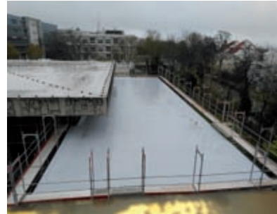
Das Dach auf dem Gemeindehaus - nachher
