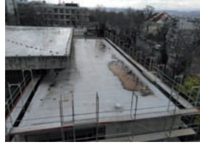
Das Dach auf dem Gemeindehaus - vorher
